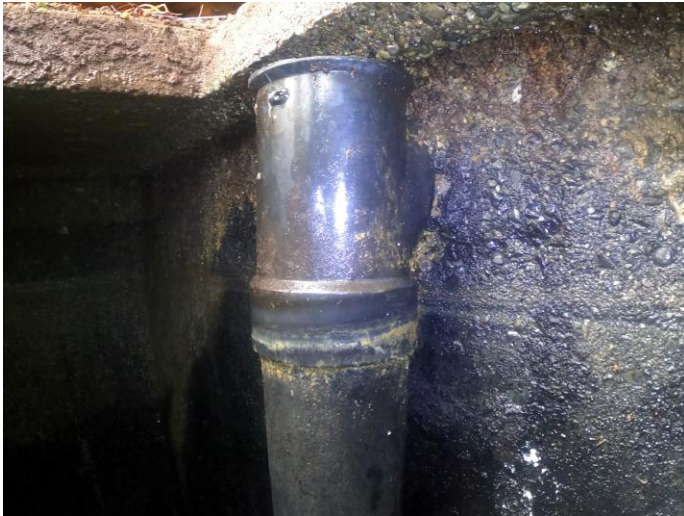
Inlet Baffle
