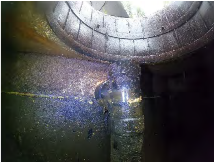
Inlet Baffle
