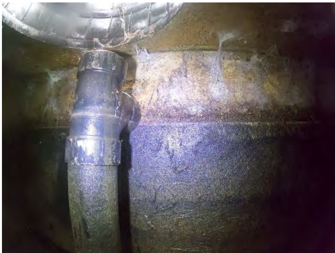
Outlet Baffle
